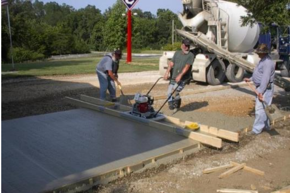
Σχ.4.2.β Ηλεκτρική κίνηση στο μηχάνημα των εργατών για εργολαβίες.
