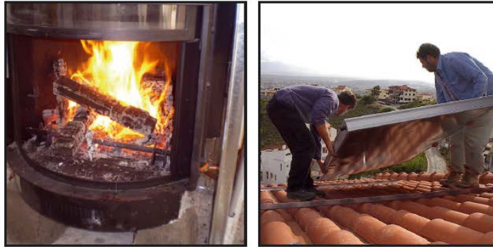
Εικόνα 2: Τοποθέτηση του ηλιακού συστήματος συλλεκτών νερού και ενεργειακού τζακιού 22.000 kcal/h, ως βοηθητικής πηγής ενέργειας, στη διώροφη ηλιακή κατοικία κ. Ουζούνη στο Ντράφι Αττικής [BONAIR, 2010].
