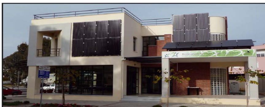
Εικόνα 1: Εγκατάσταση 20 φωτοβολταϊκών συλλεκτών στο Κοινωνικό κέντρο Παγασών του Δημοτικού Οργανισμού Υγείας και Κοινωνικών Θεμάτων (Δ.Ο.Υ.Κ) στον Βόλο. (ENERGIA 2009, Τελευταία πρόσβαση από http://www.energia.gr/article.asp?art_id=32622 )
