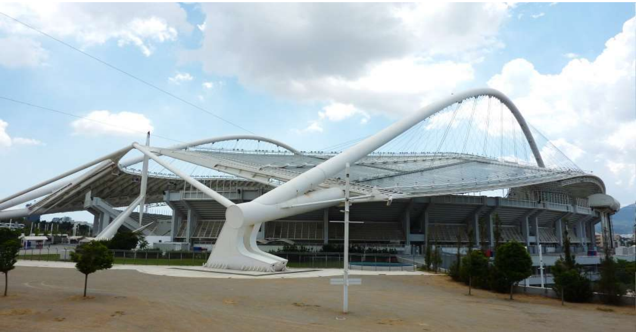
Ολυμπιακό Στάδιο Στέγαστρα
