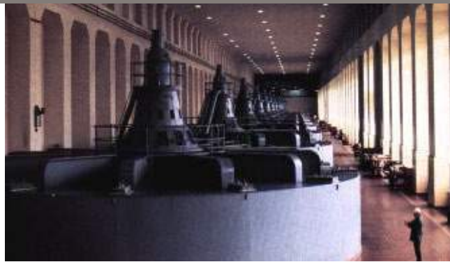
Εικ. 5.2 Ηλεκτρογεννήτριες υδροηλεκτρικού σταθμού. Η παραγωγή ηλεκτρικής ενέργειας στηρίζεται στο φαινόμενο της επαγωγής.
