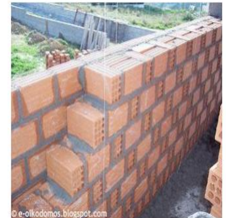
Παραλλαγή (χωρίς δεσίματα) υπερμπατικής τοιχοποιίας (πάχους 29 εκ.)
