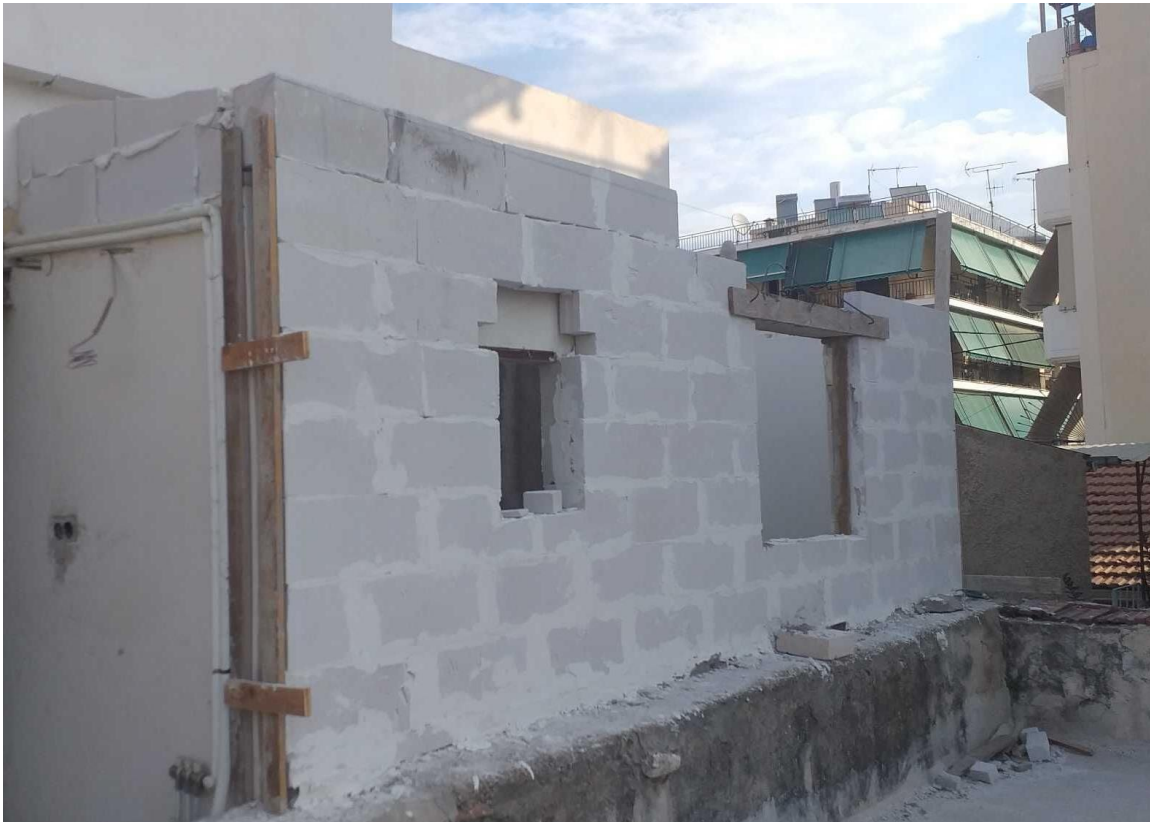
Γ.β. Πλίνθων ελαφροσκυροδέματος (Κισσηρόπλινθοι) (Πηγή oikodomikesergasies.gr )
