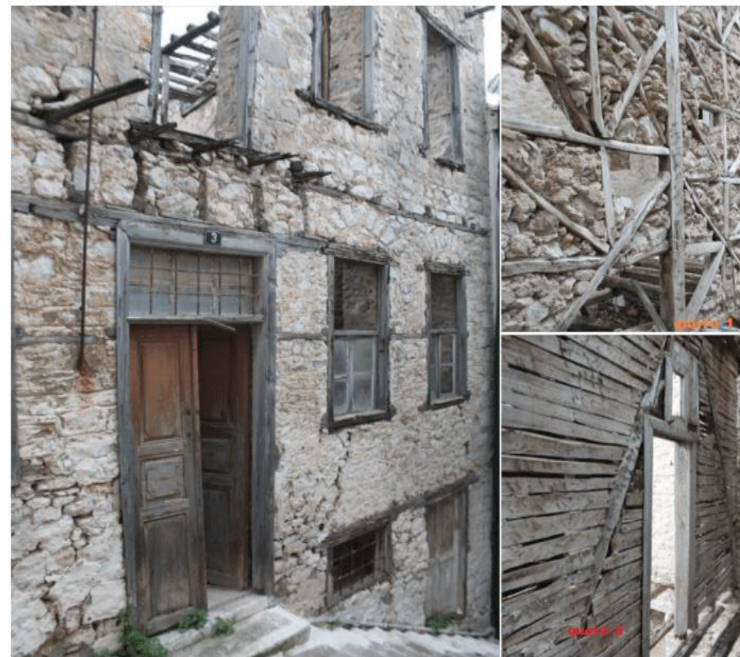
Δ.β. Ευλόπηκτες τοιχοποιίες (Τσατμάδες), (πηγή Argonafria.gr)
