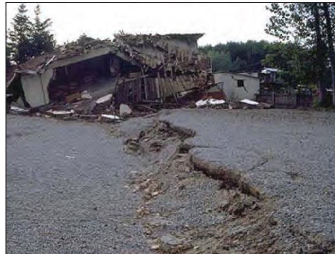
Κατάρρευση κτηρίων υπερκείμενων ρήγματος (1999 Τουρκία)
