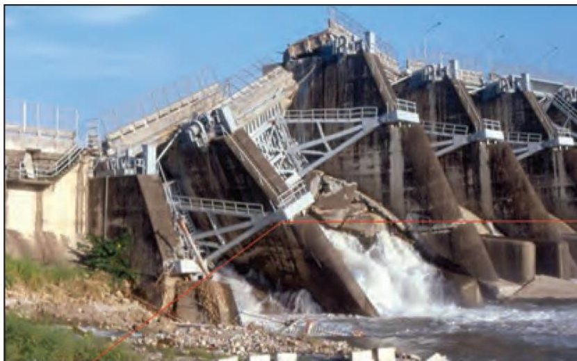
Αστοχία φράγματος λόγω κίνησης ρήγματος (ανύψωση 10 m), the (1999 Ταϊβάν)
