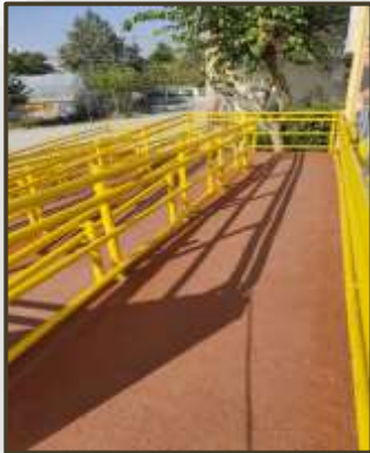
Εικόνα 61. Ράμπα από αντιολισθητικό υλικό (Ε.Ε.Ε.ΕΚ. Βόλου)
