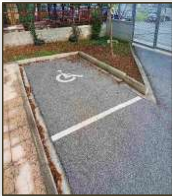
Εικόνα 28. Σήμανση πάρκινγκ ΑμεΑ (Ε.Ε.Ε.ΕΚ. Λάρισας)
