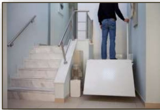
Εικόνα 18. Αναβατόριο κατακόρυφης κίνησης με πλατφόρμα (Δημουλά, κ.ά., 2023)
