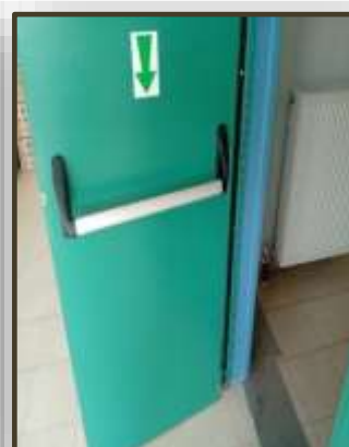
Εικόνα 56. Πόρτα που ανοίγει με μπάρα και σχετική σήμανση σε χρωματική αντίθεση από το δάπεδο (Ε.Ε.Ε.ΕΚ. Λάρισας)
