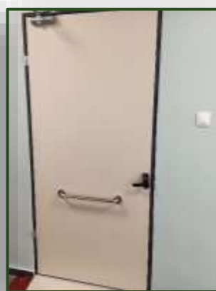
Εικόνα 189. Οριζόντια χειρολαβή και πόμολο (1 ο Γυμνάσιο Ναυπάκτου)
