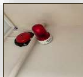
Εικόνα 204. Περιστρεφόμενη λάμπα διαδρόμου φωτεινής ειδοποίησης (Ειδικό Λύκειο Κωφών & Βαρηκόν Αγίας Παρασκευής)
