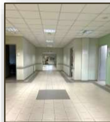
Εικόνα 52. Διάδρομος με αντιολισθητικά πλακίδια και μπάρα στήριξης (Ε.Ε.Ε.ΕΚ. Ηρακλείου Αττικής)
