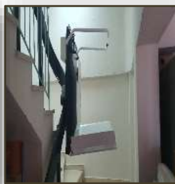
Εικόνα 97. Αναβατόριο κλίμακας με πλατφόρμα (Ε.Ε.Ε.ΕΚ. Άρτας)
