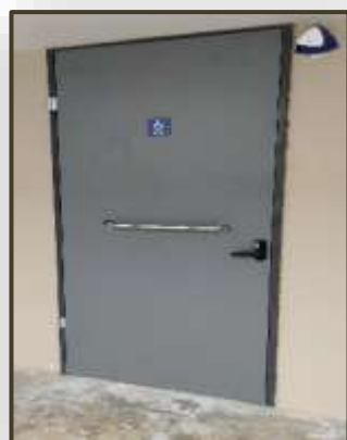
Εικόνα 182. Πόρτα με πόμολο και μπάρα (1° ΕΠΑ.Λ. Κέρκυρας)
